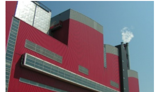
Huisvuil Centrale Alkmaar
